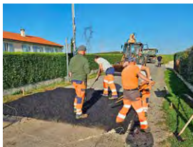
Mise en œuvre du dos d'âne
